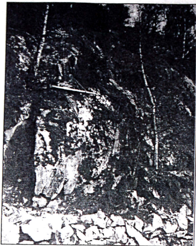
Her er det ein hamar som må skytast vekk. All boring føregjekk på gamlemåten, og det var eit tungvint og hardt arbeid. Det var særleg om hausten dei dreiv på med vegbyggingi.
